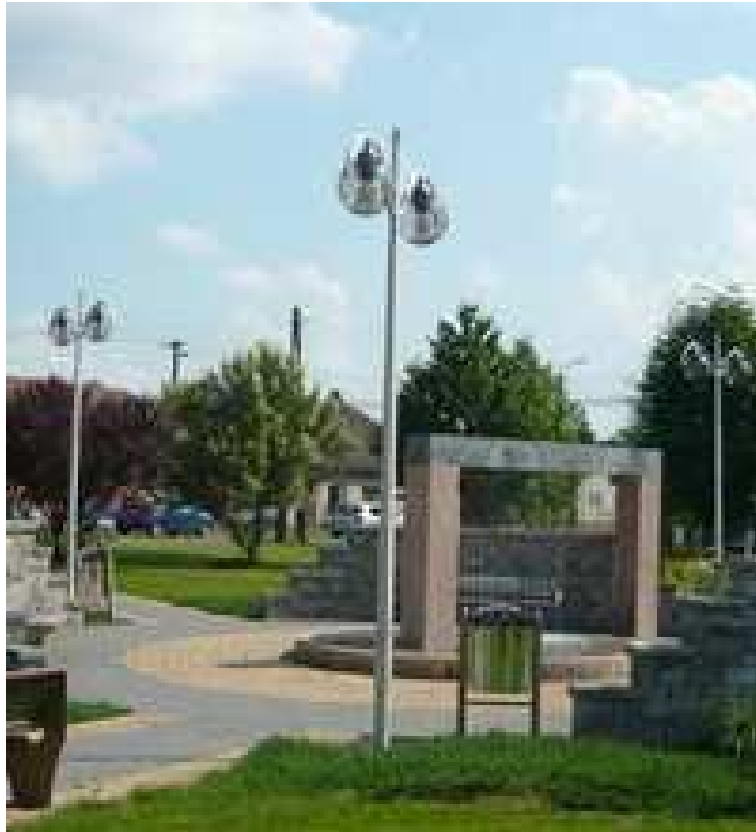
Fot. 12. Oprawa na słupie wys. 4m z kloszami w kształcie kuli.
